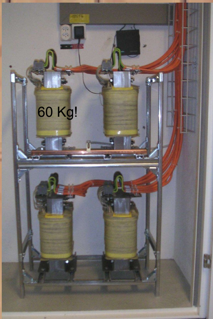
Die Sicherheitstrenntransformatoren für Notnetz 1 und 2 Les transformateurs d'isolements de sécurités, réseaux de secour 1 et 2
