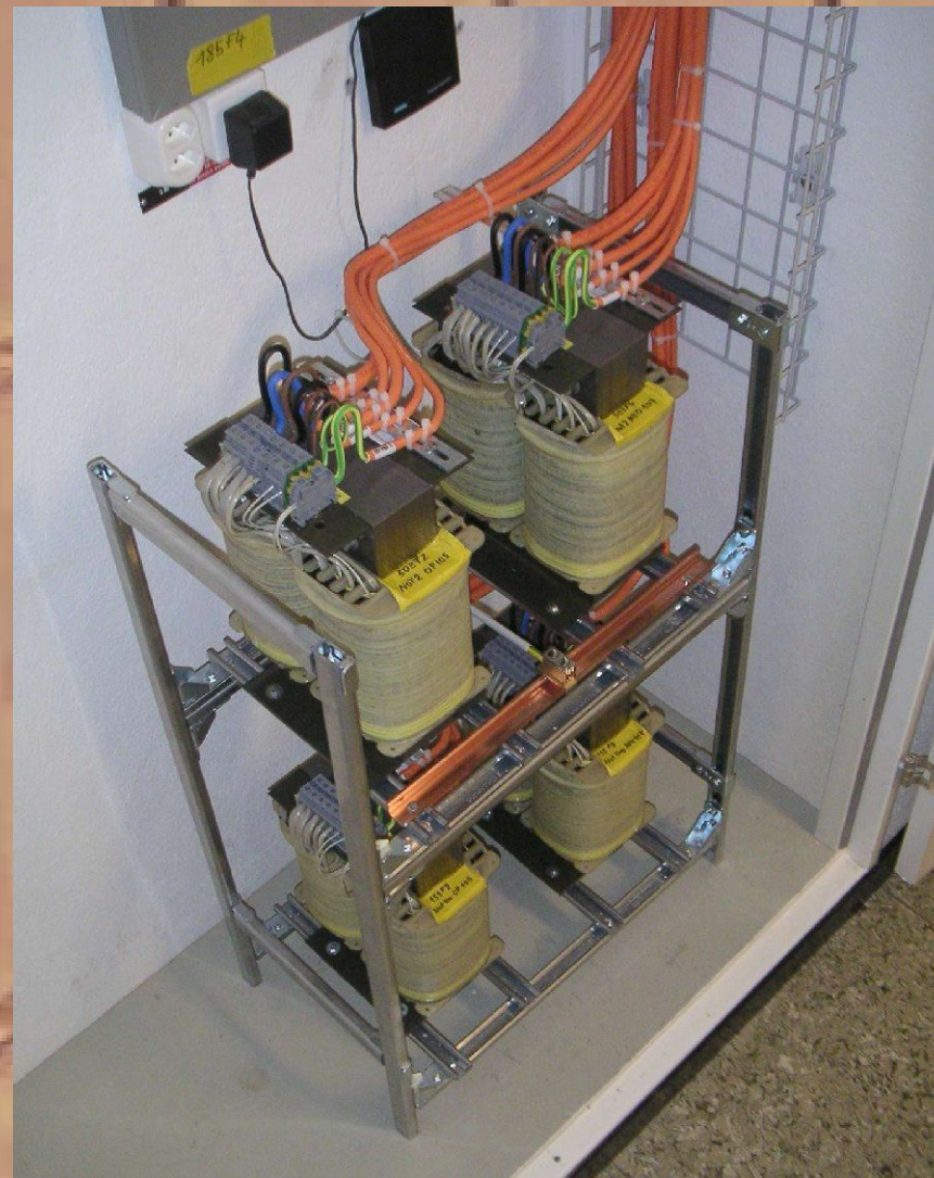
Die Sicherheitstrenntransformatoren für Notnetz 1 und 2 Les transformateurs d'isolements de sécurités, réseaux de secour 1 et 2
